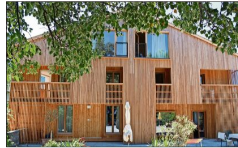
Gänzlich in Holz neu gestaltet wurde die Ostfassade.
