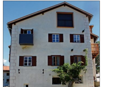
Die steinernen Fassaden behielten die Dimensionen ihrer Fenster.
